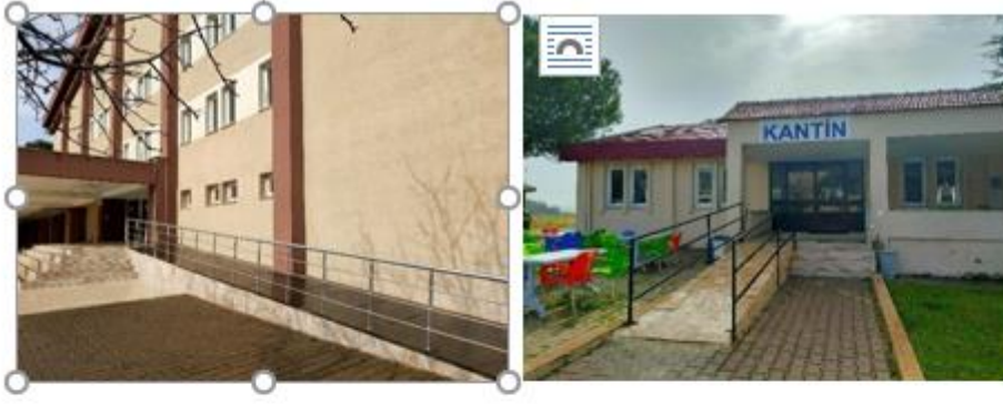
Resim 1. Yapı girişlerinde yer alan rampalar.
